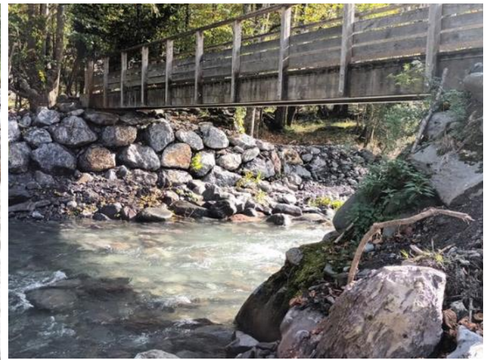
Les rives ont été confortées pour le nouveau passage
