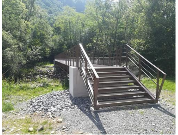
La nouvelle passerelle désormais en place
